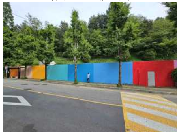
노후 마을벽화 개선사업 도장공사 공사 전
