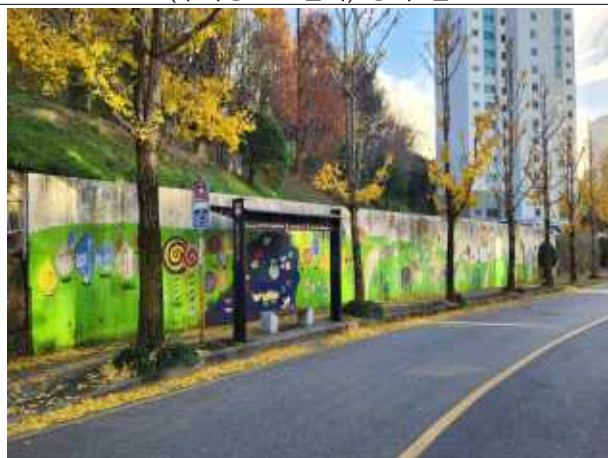
노후 마을벽화 개선사업 도장공사 공사 전
