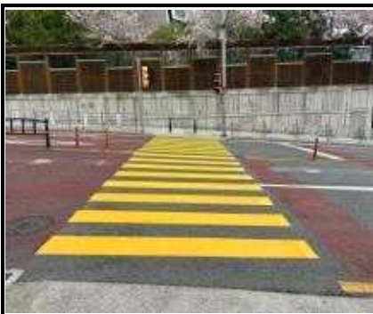
(24. 4.)금정구 어린이보호구역 횡단보도 정비공사
