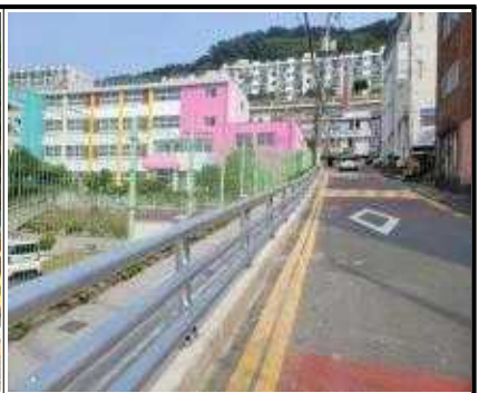
(24. 6.)어린이보호구역 방호울타리 설치공사
